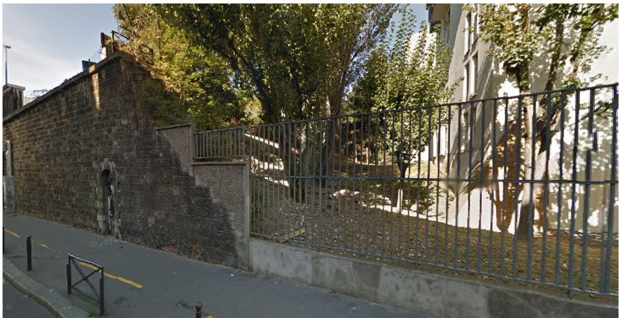
Rue de Lagny, Paris
